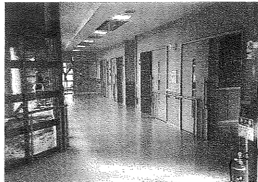
居住棟(女子寮) 廊下~居室出入口まわり
