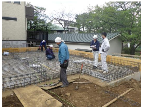
確認・保険機関の配筋検査 滞りなく行われている
