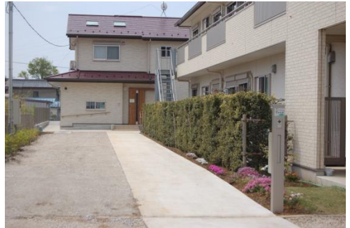
奥が3月に竣工したグループホーム 手前右は一昨年竣工
