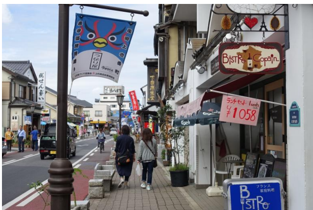
無電柱化され2mセットバックして確保された歩道
