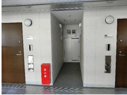
旧警備室が主戸に取り込まれて玄関になっている
