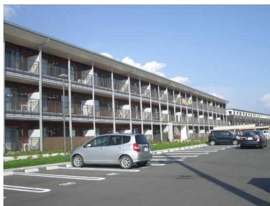
図 3 石倉復興公営住宅(二本松市)
