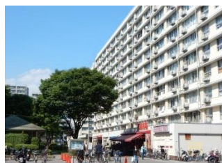
写真—7 エヤ・コン室外機
