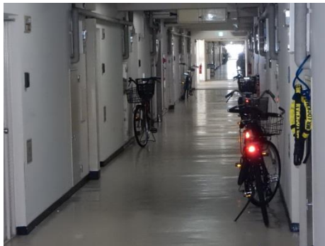
写真一 大島6丁目 中廊下と玄関ドア
